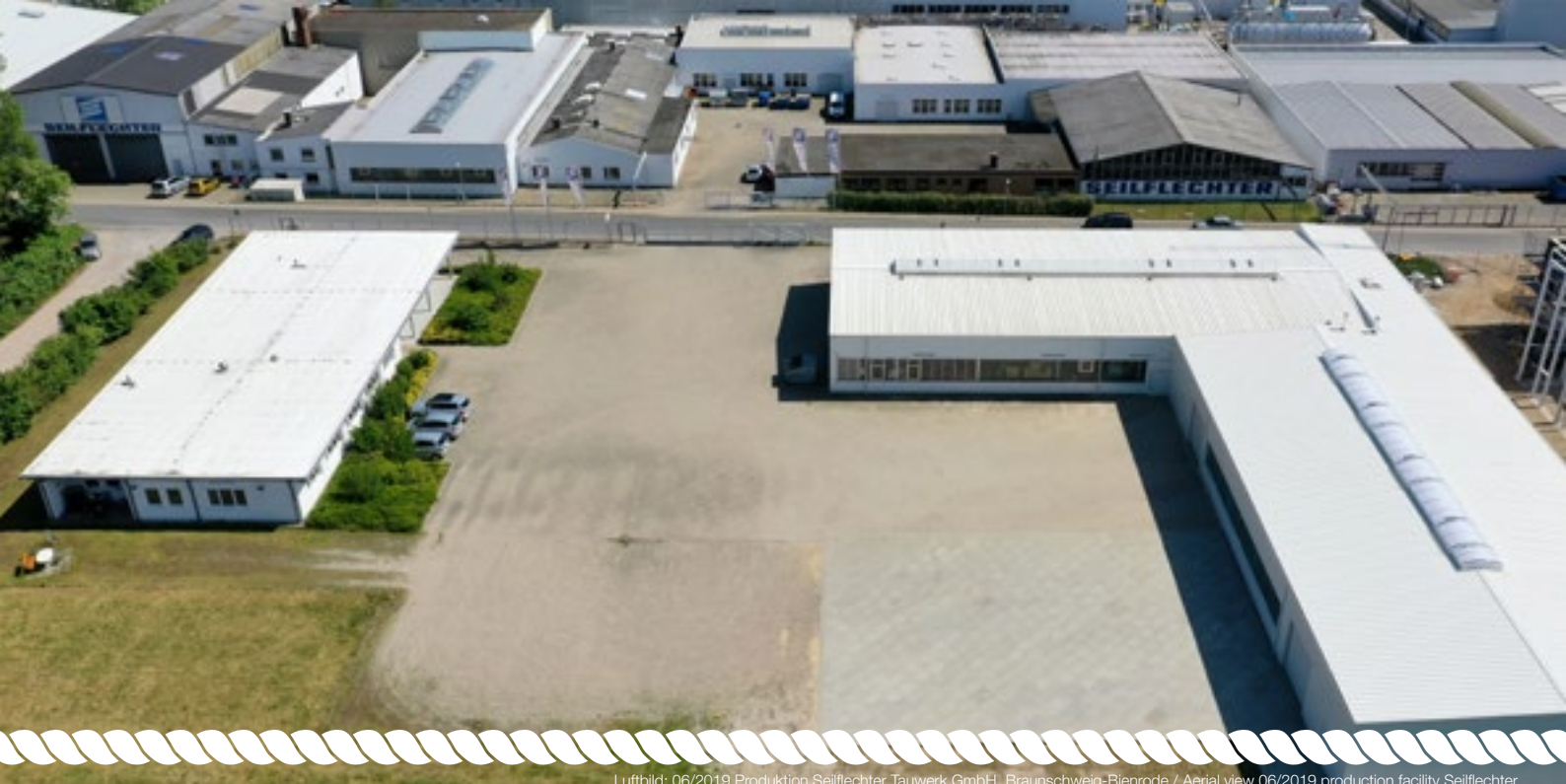
Luftbild: 06/2019 Produktion Seilflechter Tauwerk GmbH, Braunschweig-Bienrode / Aerial view 06/2019 production facility Seilflechter
